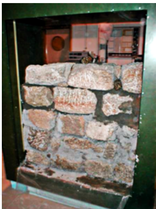
Figura 1 - Fase intermédia da construção da parede.
